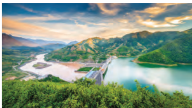
Hình 2.2. Nhà máy thủy điện Sơn La (Sơn La)
