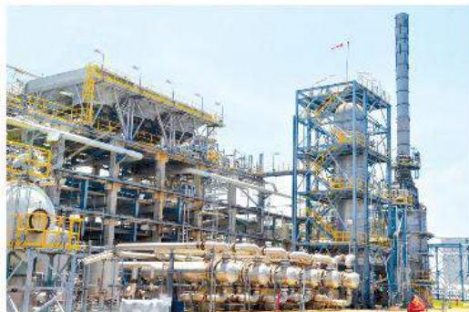
▲ Hình 9.2. Một góc của nhà máy lọc dầu Dung Quất
