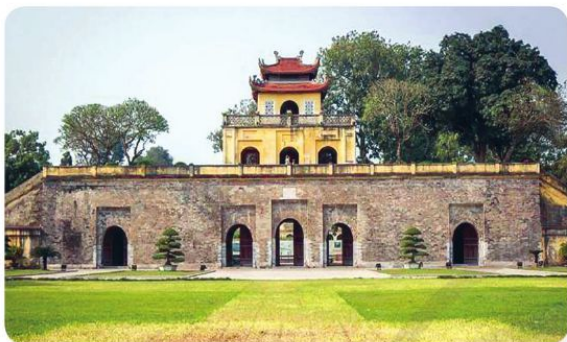
Hình 2.12. Đuan môn (cổng chính phía nam dẫn vào khu Cấm thành – Hoàng thành Thăng Long)
