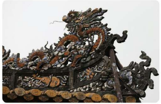
Hình 40. Hình rồng gắn sành, sứ trên đầu đao điện Thái Hoà (Đại Nội, Huế)
