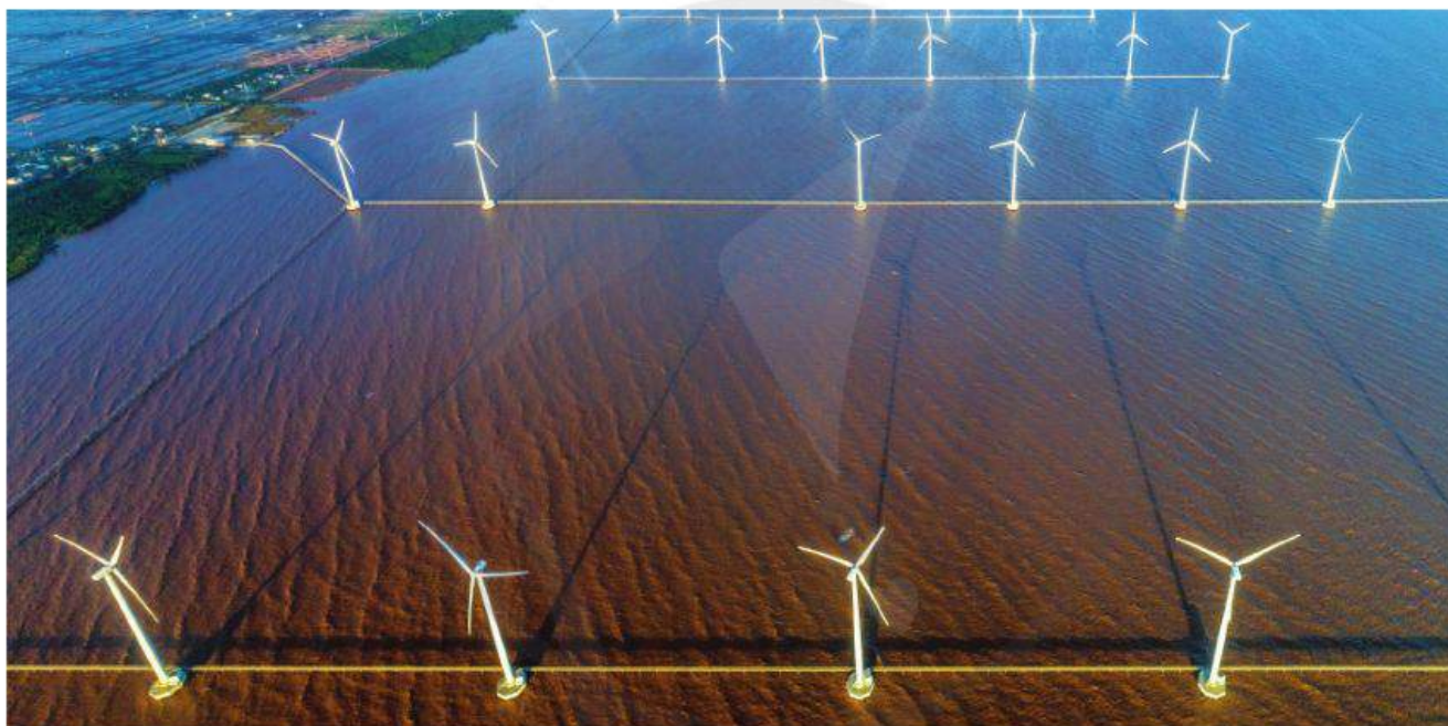
Hình 3.11. Các tua bin gió ở tỉnh Bạc Liêu
