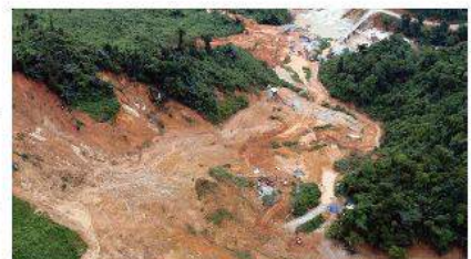
▲ Hình 9.15. Sạt lở ở thủy điện Rào Trăng 3 (Thừa Thiên Huế) vào tháng 10/2020
