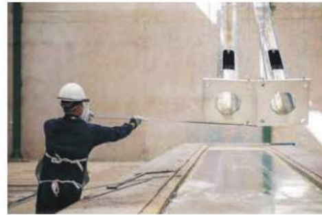
b) Xử lý bề mặt cột điện
