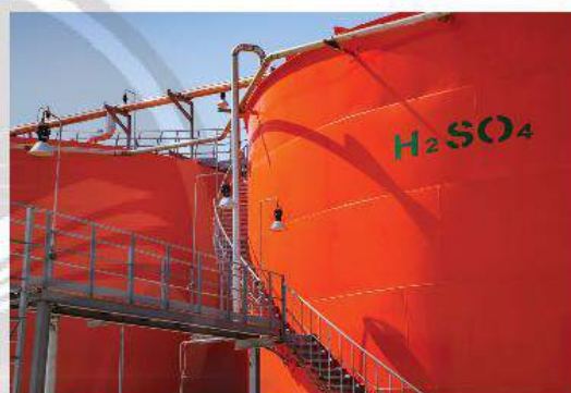
▲ Bồn chứa sulfuric acid của một nhà máy sản xuất
