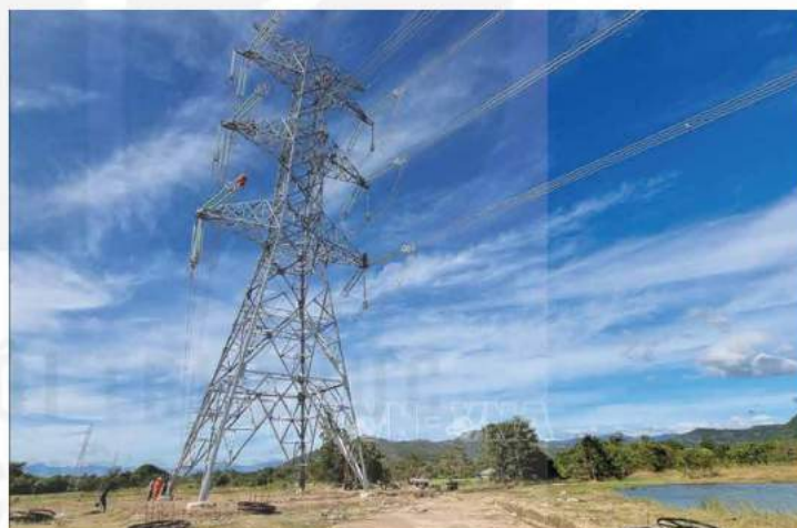
Hình 4. Công trình đường dây điện 500 kV, đoạn qua huyện Bác Ái (Ninh Thuận)
