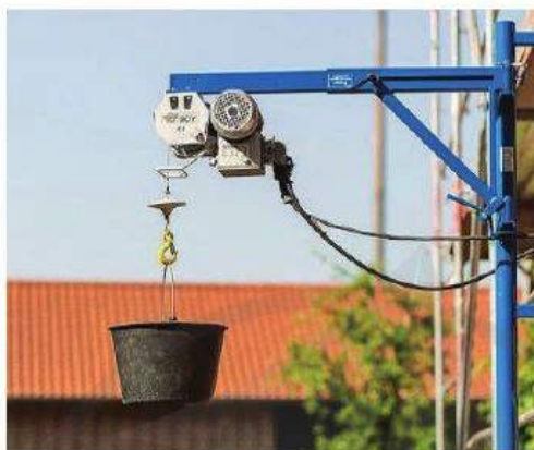
b) Đưa vật liệu lên cao bằng máy tời điện
