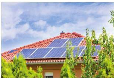
Hình 5. Nhà có sử dụng pin mặt trời
