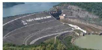
Hình 1.2. Nhà máy thủy điện Hoà Bình
