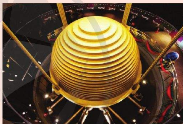
Hình 4.1. Con lắc giảm chấn treo tại nóc toà nhà Đài Bắc 101
