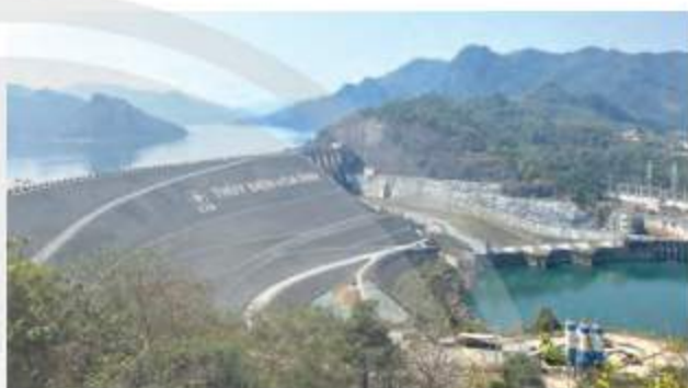
▲ Hình 13.1. Nhà máy thủy điện Hoà Bình
