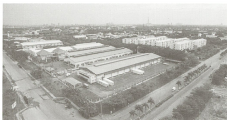
Khu công nghiệp Long Hậu - Long An
